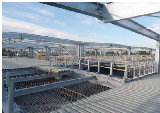
© Briand Construction Métallique
