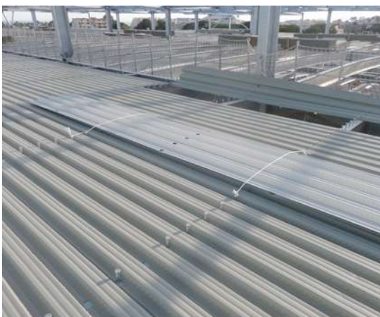
© Briand Construction Métallique
