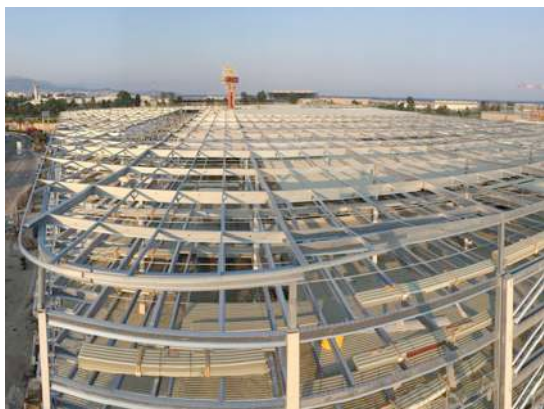
© Briand Construction Métallique
