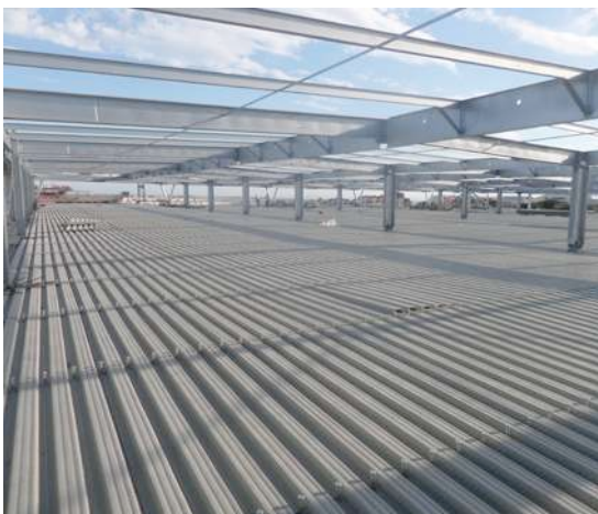
© Briand Construction Métallique
