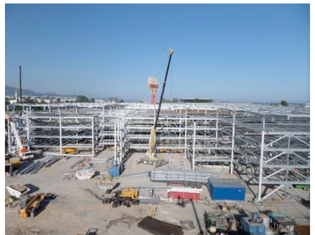
© Briand Construction Métallique
